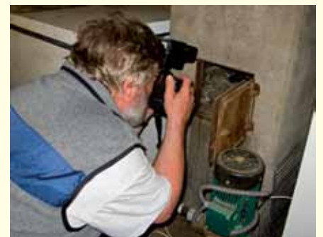
Dyretegneren Viggo Ree fotograferte kaieungene inne i bunnen av skorsteinen.
